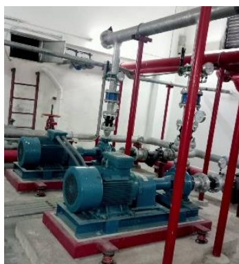
ปั๊ม และถังสำรองเพื่อการอุปโภค-บริโภค และดับเพลิง (ชั้นใต้ดิน)
