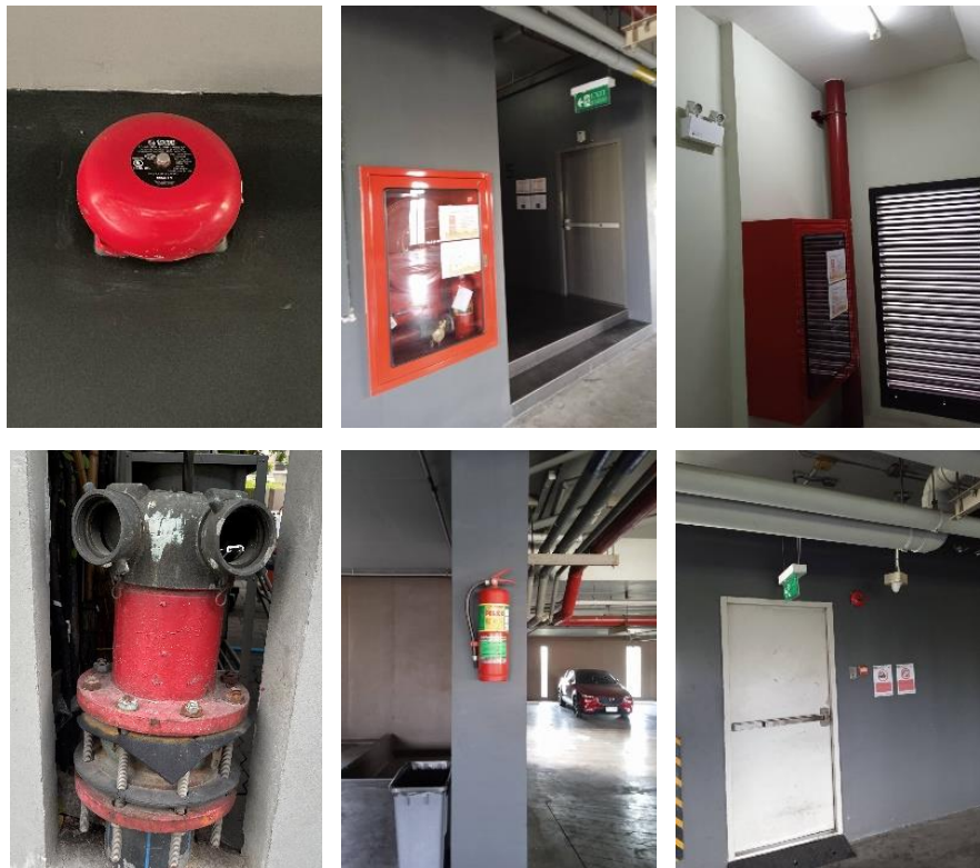
กระดิ่งสัญญาณ , ตู้เก็บสายฉีดน้ำดับเพลิงพร้อมอุปกรณ์และป้ายแนะนำอุปกรณ์ ระบบหัวกระจายน้ำดับเพลิง , หัวรับน้ำดับเพลิง
