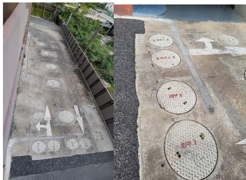
ระบบบำบัดน้ำเสีย (บ่อดักไขมัน บ่อเกรอะ, บ่อปรับ สภาพ บ่อเติมอากาศ บ่อดกตะกอน และบ่อเก็บ ตะกอน)
