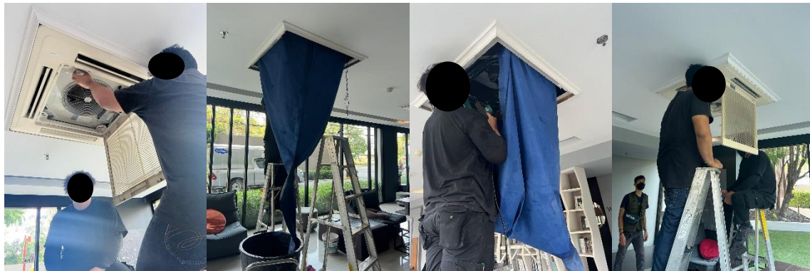
เจ้าหน้าที่ทำความสะอาดเครื่องปรับอากาศประจำทุก 6 เดือน
