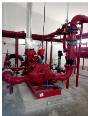
ปั๊ม และถังสำรองเพื่อการอุปโภค-บริโภค และดับเพลิง (ชั้นใต้ดิน)
