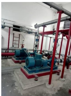
ปั๊ม และถังสำรองเพื่อการอุปโภค-บริโภค และดับเพลิง (ชั้นใต้ดิน)
