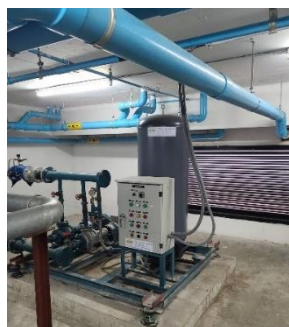
ปั๊ม และถังสำรองเพื่อการอุปโภค-บริโภค (ชั้นดาดฟ้า)
